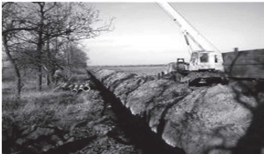
Рисунок 4. Демонтаж зрошувальної мережі у Миколаївській області
