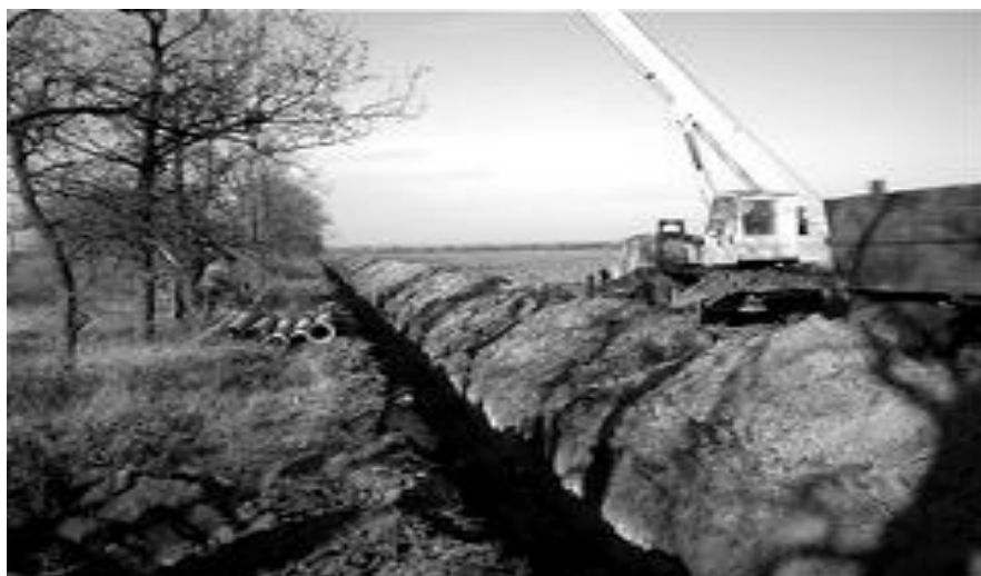
Рисунок 4. Демонтаж зрошувальної мережі у Миколаївській області
